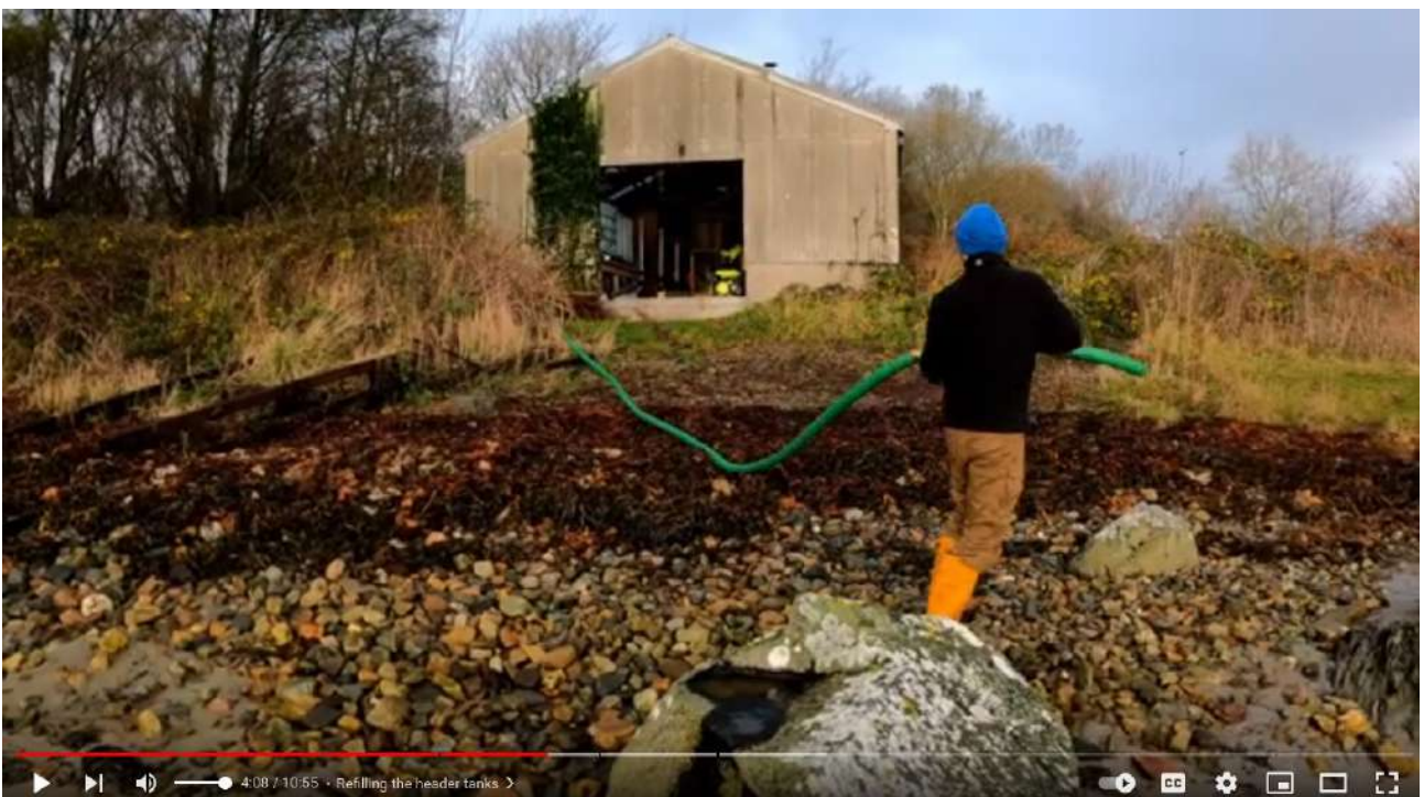
Le tuyau de rechargement des bacs de tête. On voit aussi le bâtiment de l'extérieur : un ancien hangar à bateau semble-t-il...
