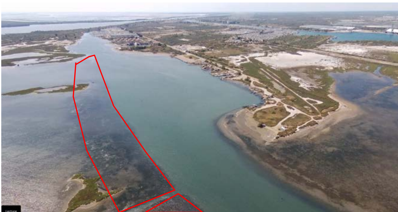
Figure 26: Le drone pointe vers l'ouest, vers la darse conchylicole. Sur cette partie aussi, la bande de zostères marines au sud du chenal est plus large que celle au nord
